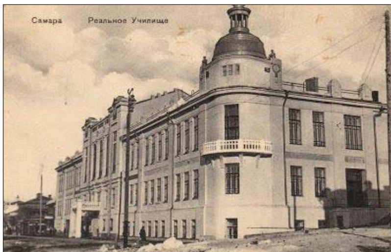
Здание Самарского реального училища после реконструкции в 1909 году
